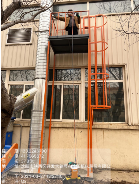
A2.2 齿轮车间淬火排气筒出口
