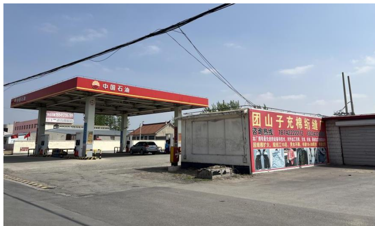
图4.2-2 中国石油天然气股份有限公司辽宁鞍山海城兴海德胜加油站
